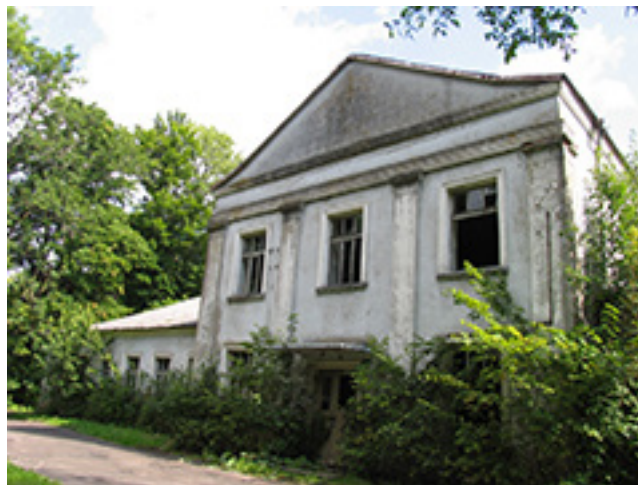
Nykstantys Vilkėno dvaro sodybos pastatai 2008 m. Apačioje – 1958 m. rekonstruotos, mokyklos veiklai pritaikytos dvaro arklidės. Danutės Mukienės nuotraukos
