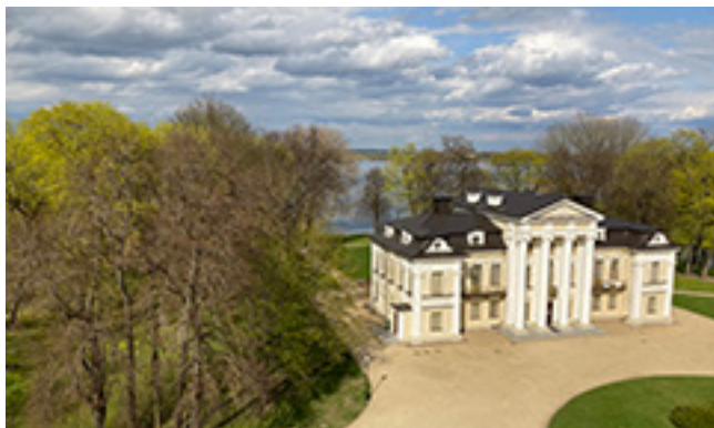
Paežerių dvaro centriniai rūmai, kuriuose veikia Vilkaviškio rajono Suvalkijos (Sūduvos) kultūros centras-muziejus. Nuotrauka iš Lietuvos pilių ir dvarų asociacijos archyvo
