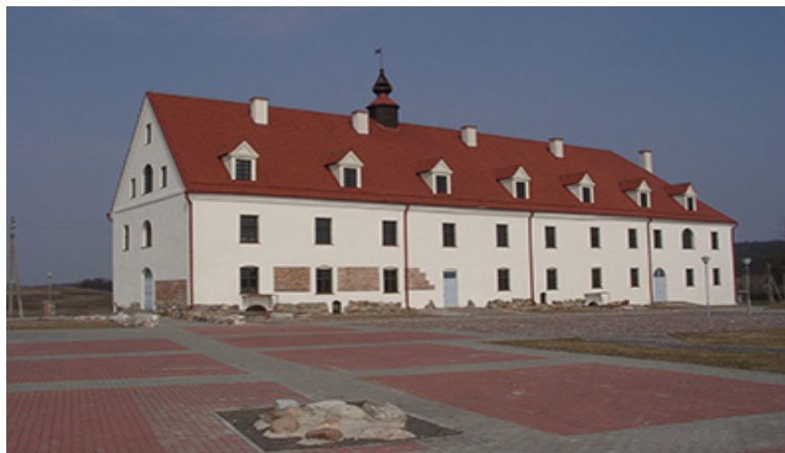
Restauruotas Kražių kolegijos mokinių bendrabučio pastatas (bursa). D. Mukienės nuotrauka
