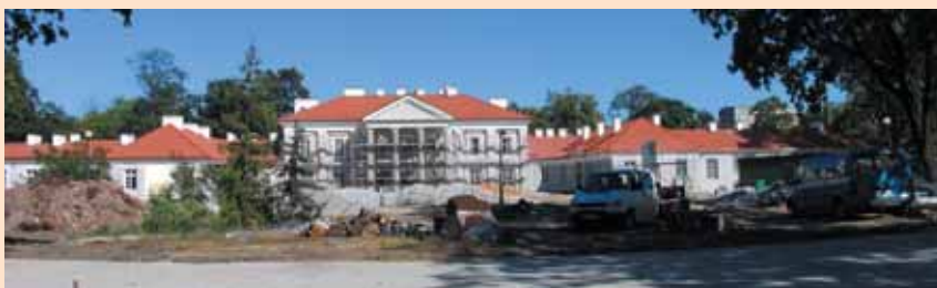
Restauruojami Sedlcų (Lenkija) dvaro rūmų pastatai. 2006 m.
