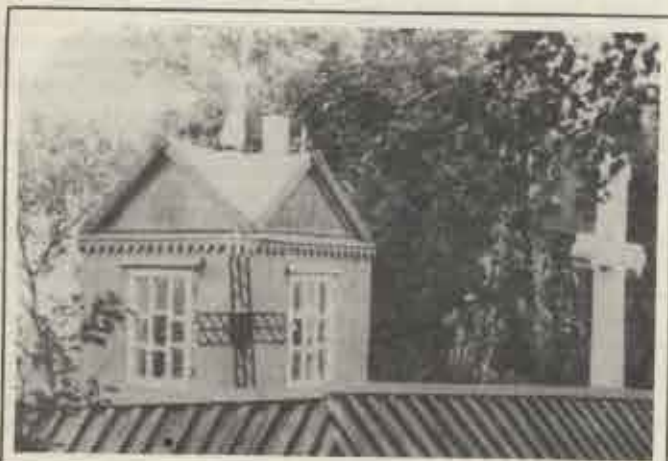
GARBĒS KALNELIO KOPLYČIA
